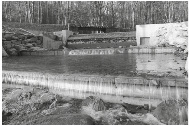
Рис. 2. Водозабір та рибихід міні-ГЕС «Шипот-2» на притоці Шипот річки Тур'я поблизу села Тур'я Поляна Закарпатської області.
