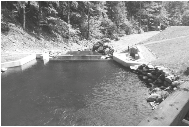
Рис. 2. Водозабір та рибихід міні-ГЕС «Шипот-2» на притоці Шипот річки Тур'я поблизу села Тур'я Поляна Закарпатської області.
